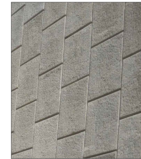
M.S.E. WALL BRUSHED CONCRETE FINISH N.T.S.
