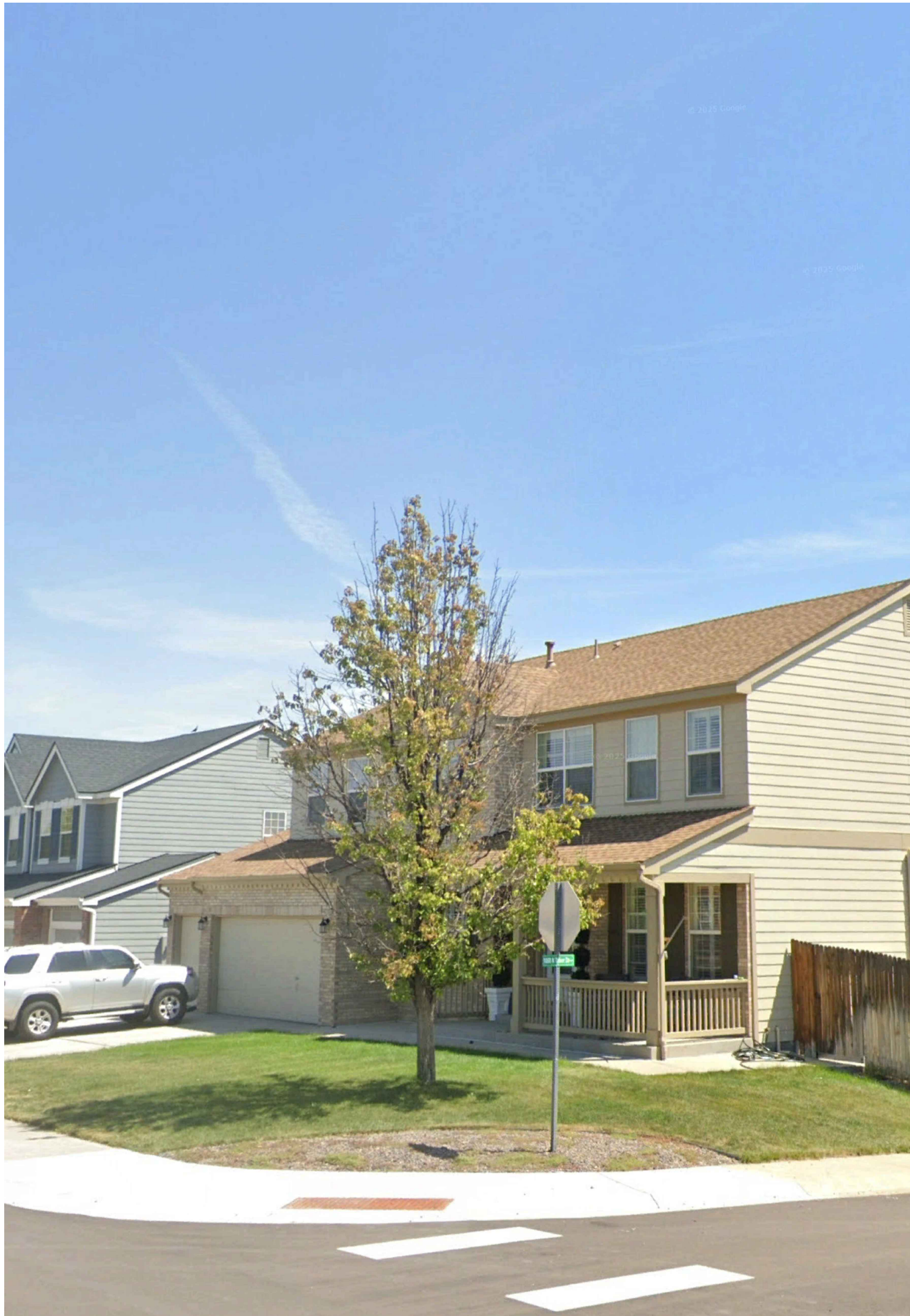
1 EXISTING CONDITIONS PHOTO P-1 SCALE: N.T.S.
