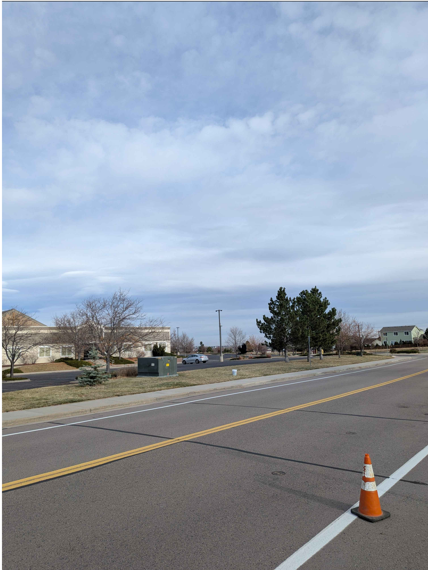
1 EXISTING CONDITIONS PHOTO P-1 SCALE: N.T.S.
