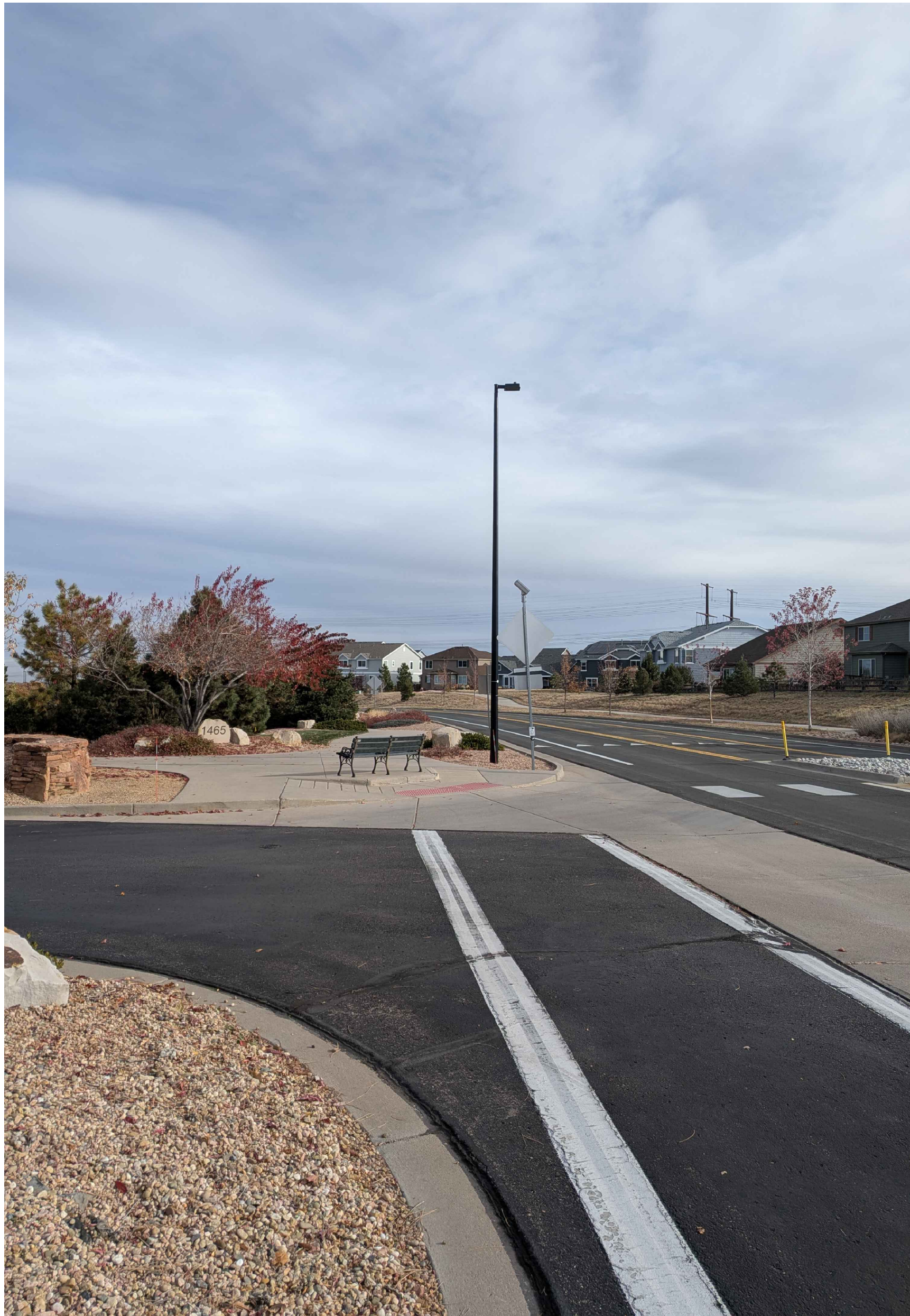
1 P-1 EXISTING CONDITIONS PHOTO SCALE: N.T.S.
