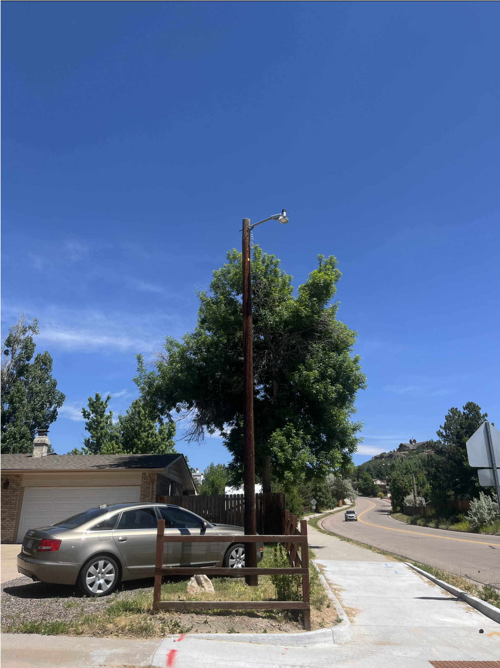
1 EXISTING CONDITIONS PHOTO P-1 SCALE: N.T.S.
