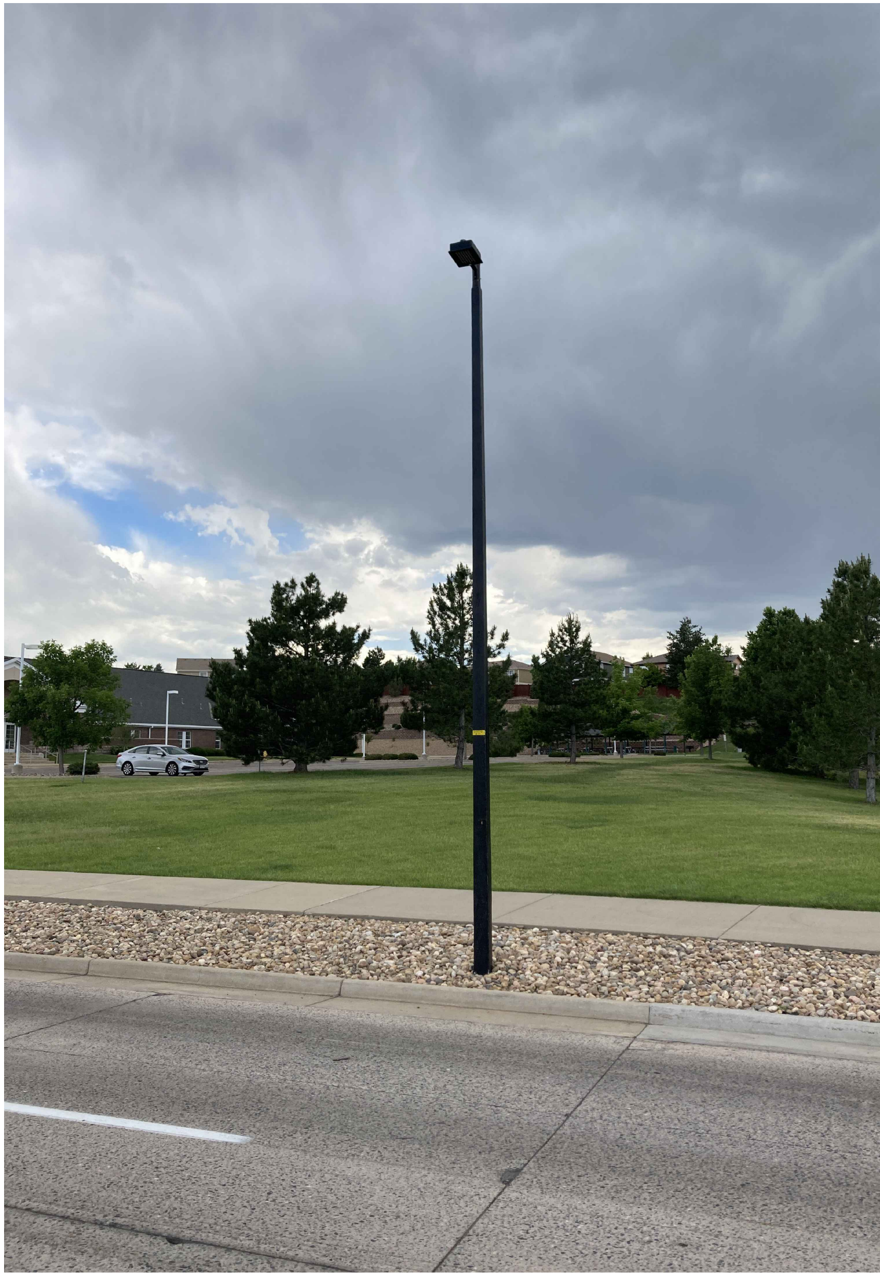
1 EXISTING CONDITIONS PHOTO P-1 SCALE: N.T.S.
