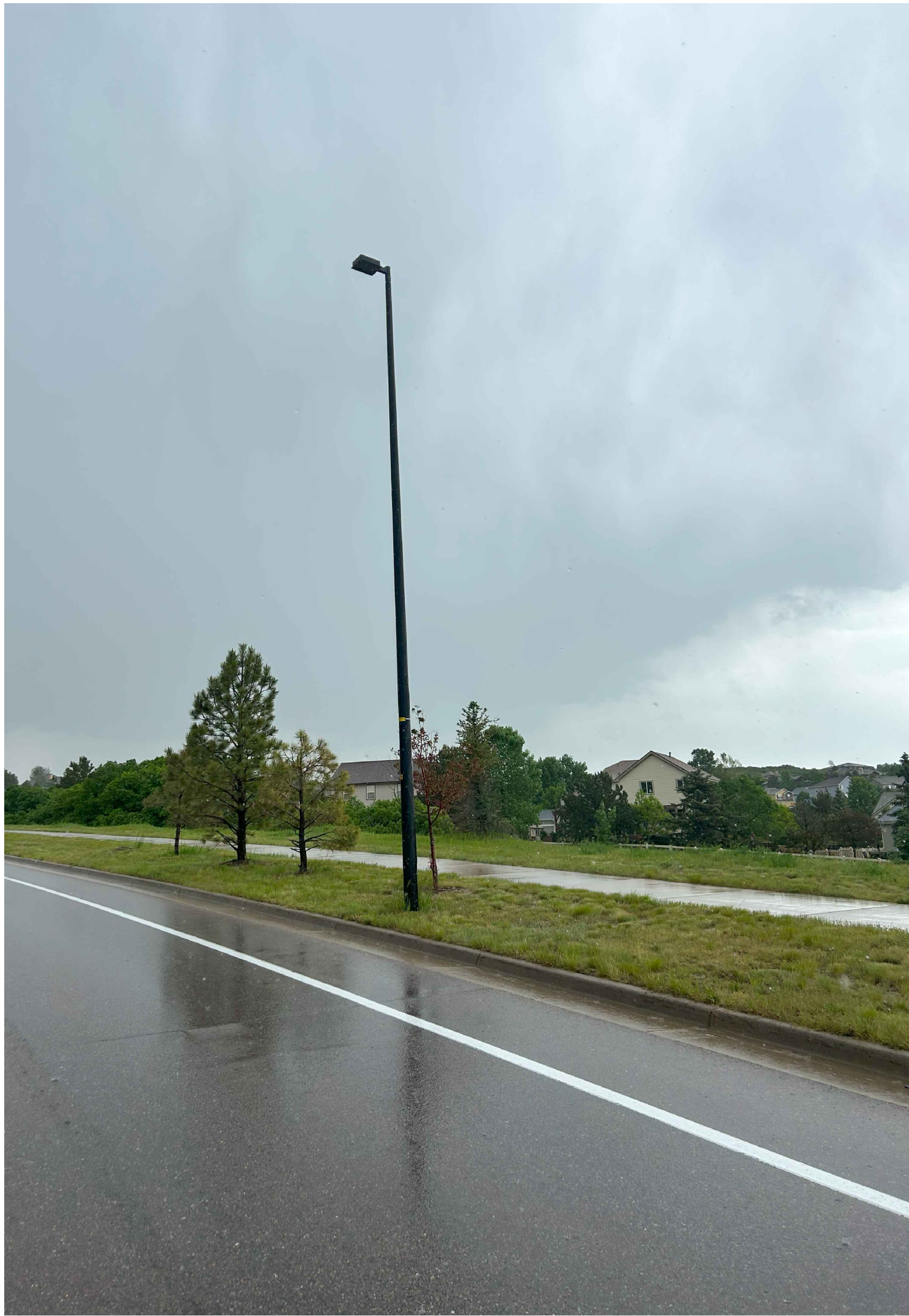
1 EXISTING CONDITIONS PHOTO P-1 SCALE: N.T.S.
