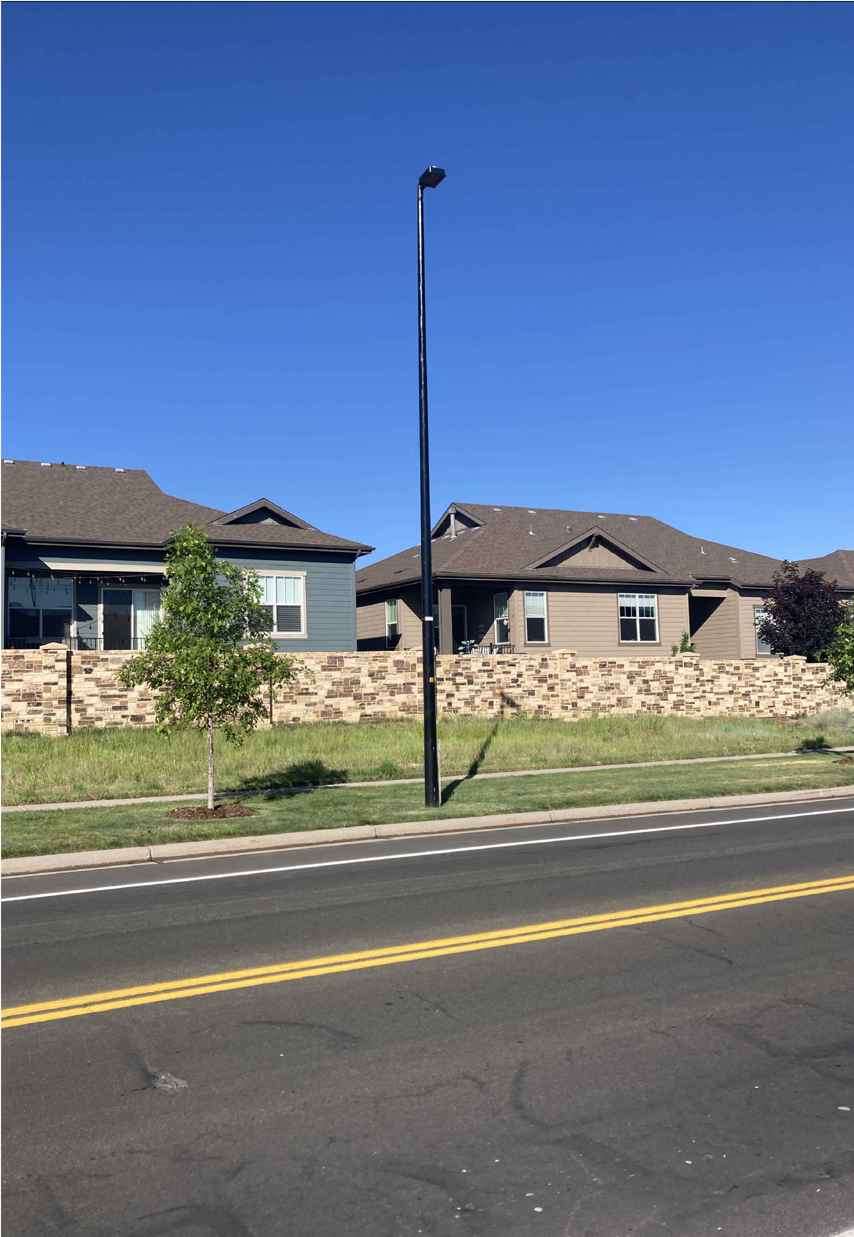
1 EXISTING CONDITIONS PHOTO P-1 SCALE: N.T.S.
