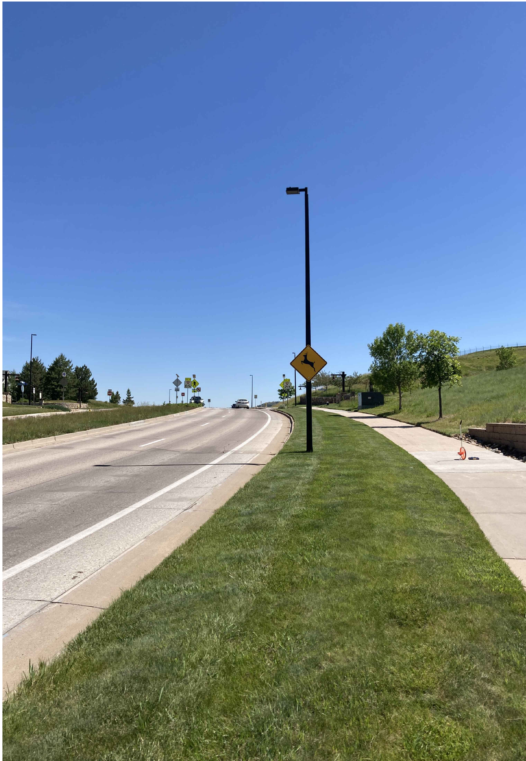
1 EXISTING CONDITIONS PHOTO P-1 SCALE: N.T.S.
