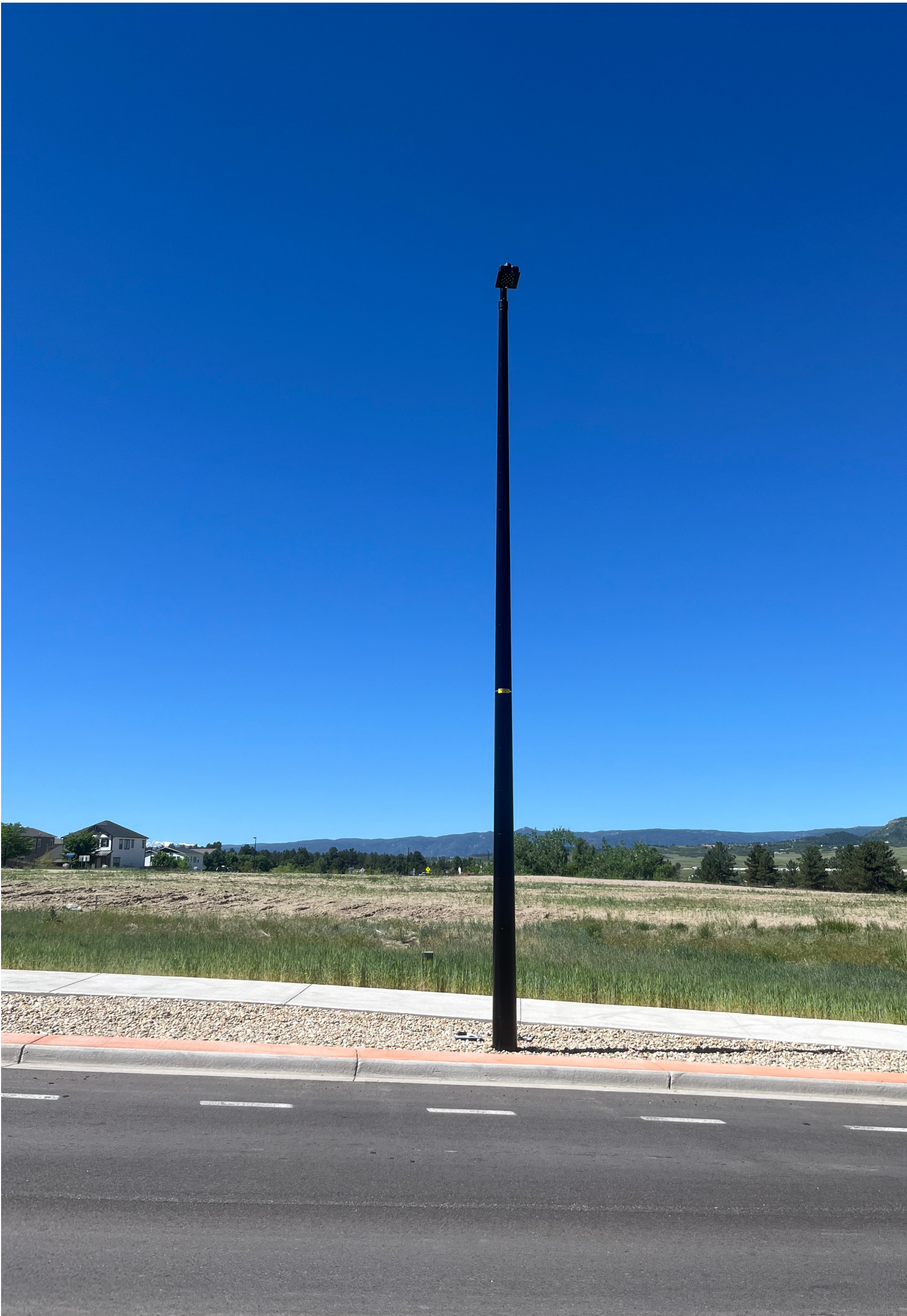
1 P-1 EXISTING CONDITIONS PHOTO SCALE: N.T.S.
