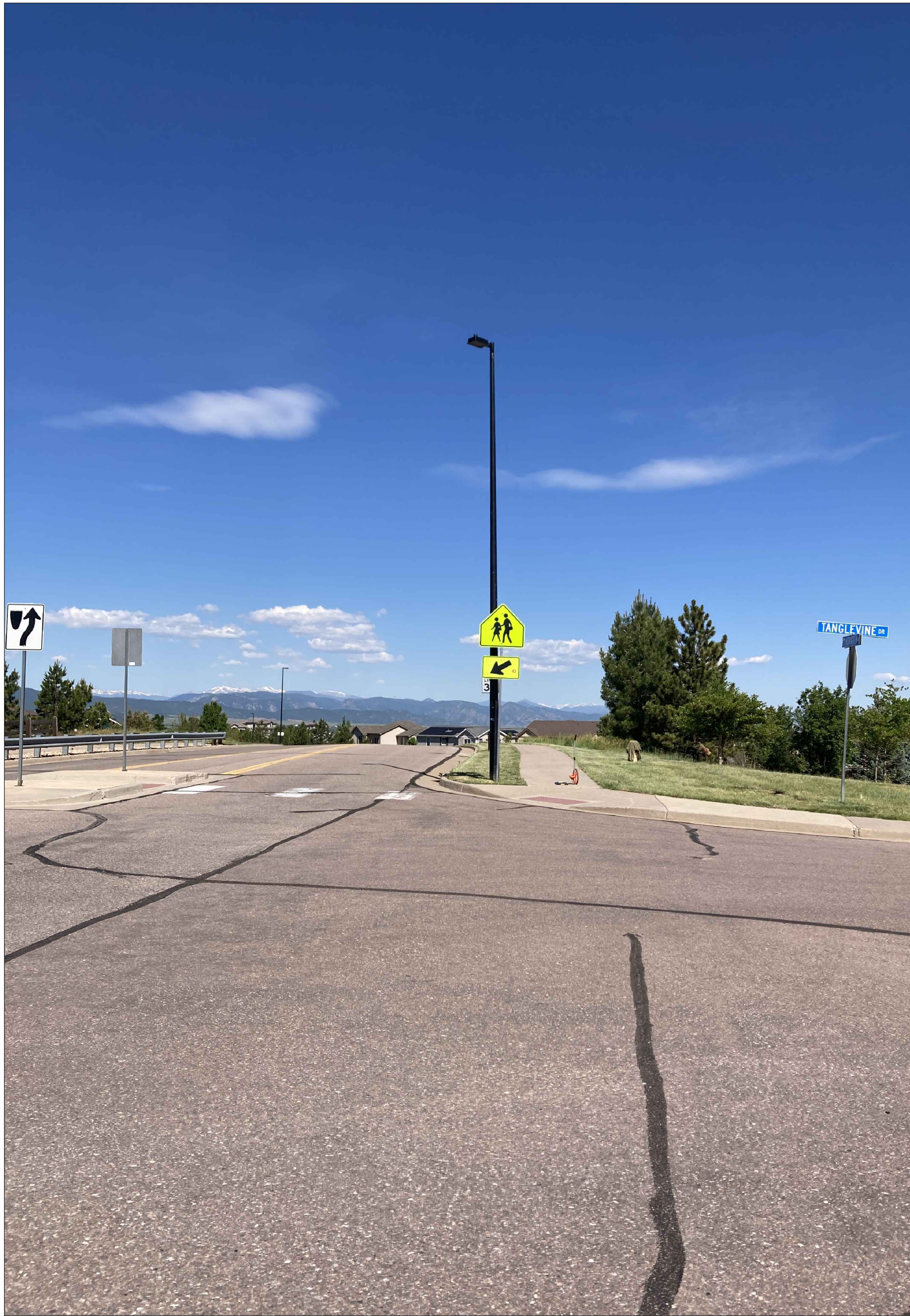
1 EXISTING CONDITIONS PHOTO P-1 SCALE: N.T.S.
