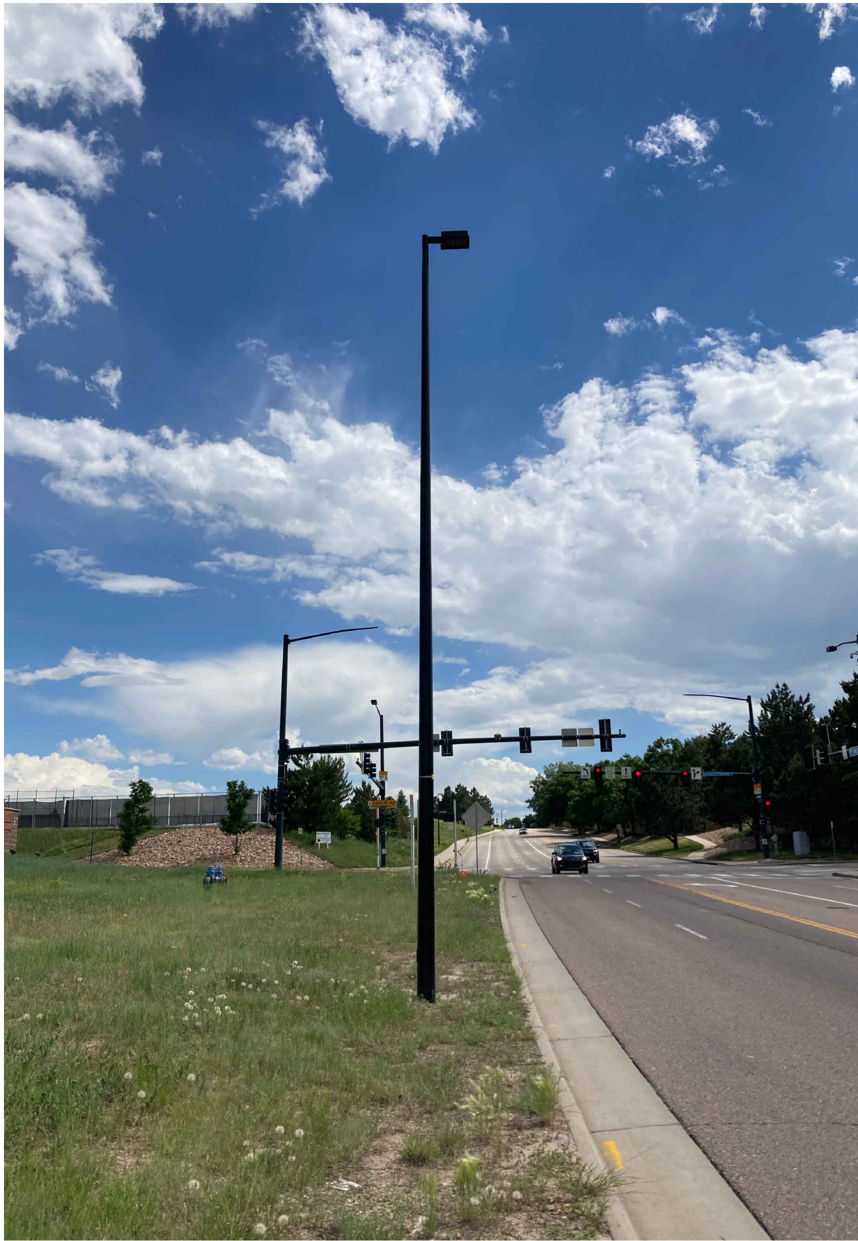
1 EXISTING CONDITIONS PHOTO P-1 SCALE: N.T.S.
