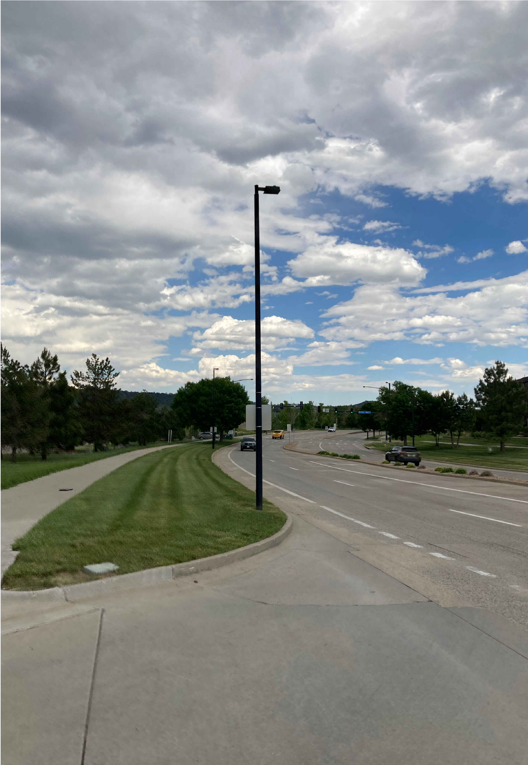
1 EXISTING CONDITIONS PHOTO P-1 SCALE: N.T.S.
