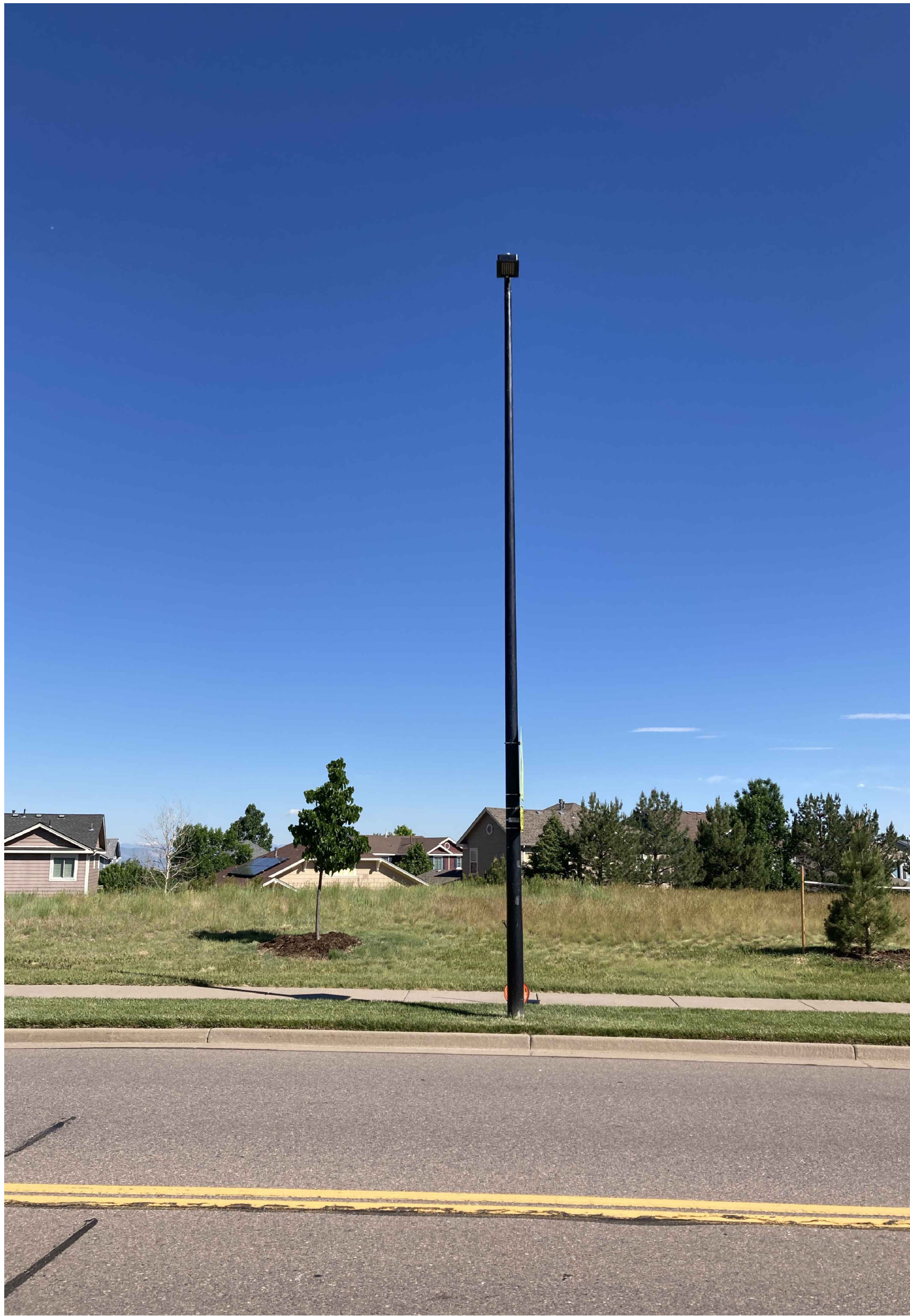
1 EXISTING CONDITIONS PHOTO P-1 SCALE: N.T.S.
