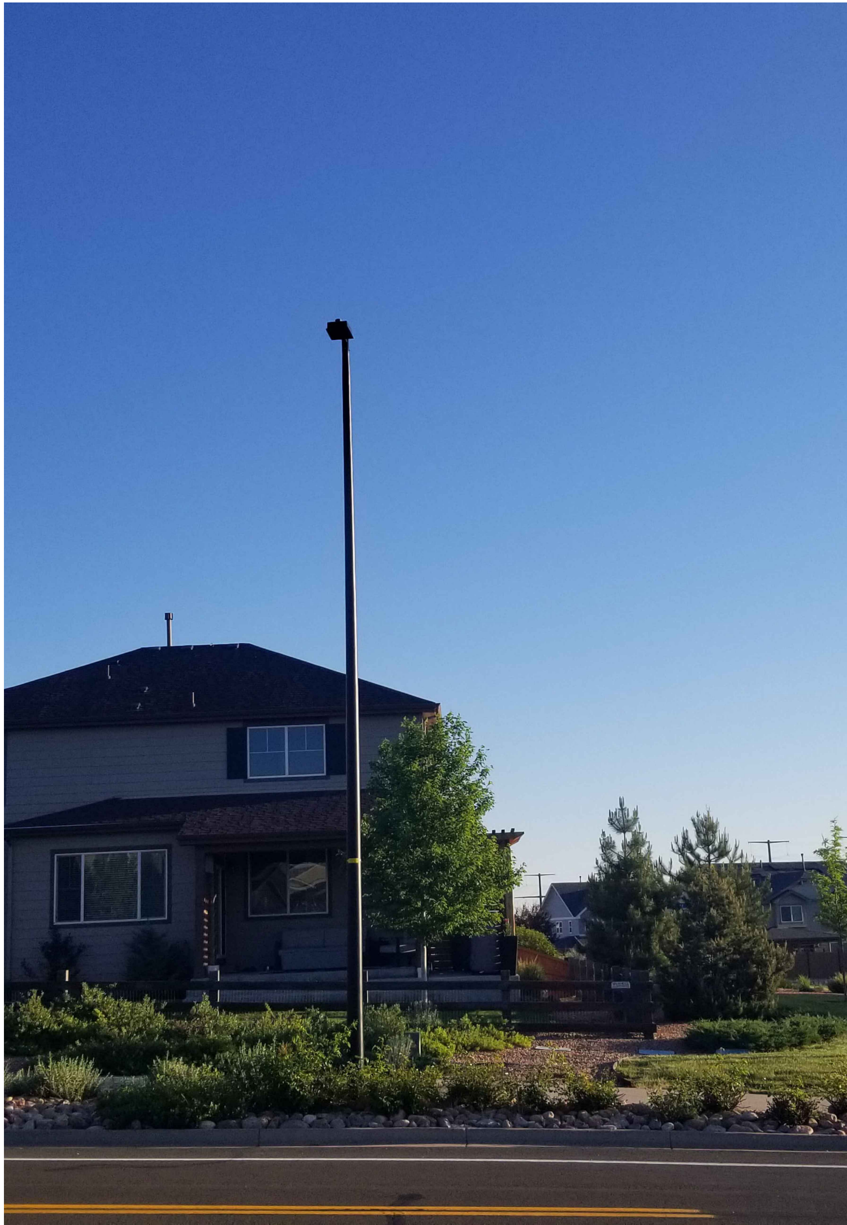
1 EXISTING CONDITIONS PHOTO P-1 SCALE: N.T.S.
