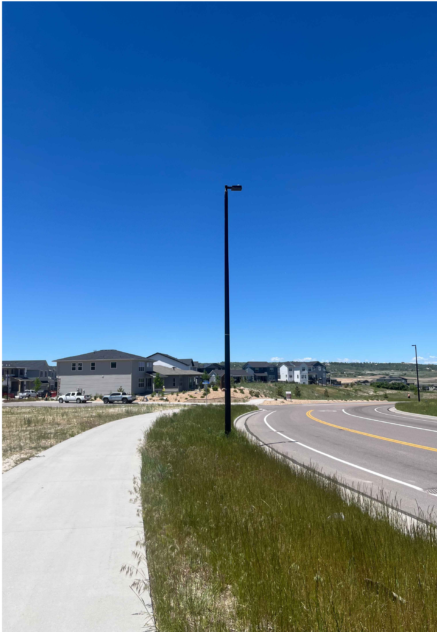
1 EXISTING CONDITIONS PHOTO P-1 SCALE: N.T.S.
